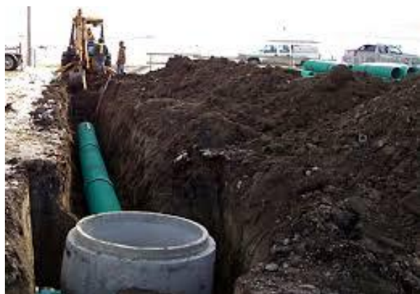
Slika 5. Postavljanje nove cijevi [33]
