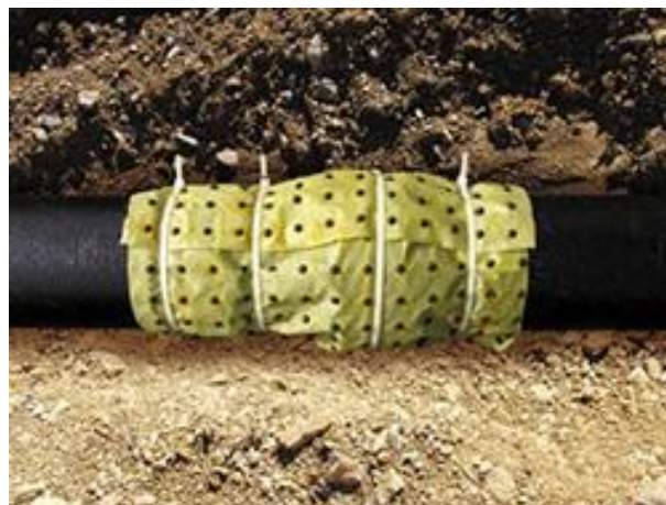
Slika 3. Geotekstil s herbicidom postavljen na spoju dvije cijevi [31]
