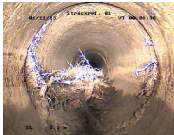
Slika 1. Korijenje koje je prodrlo kroz spoj dvije cijevi [22]
