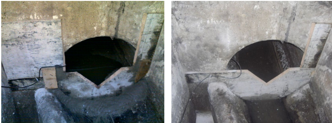
Slika 7 - Postavljanje, učvršćivanje i brtvljenje preljeva
