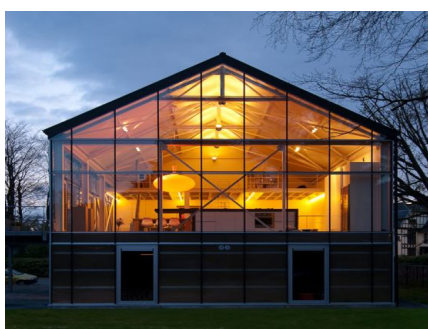
Slika 18a - Obiteljska kuća- Asse, Belgija
