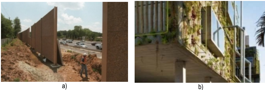
Slika 7 - Vertikalni elementi od propusnog betona: a) bukobran, [20]; b) pročelje uredske zgrade, [21] (slike uredili autori)
