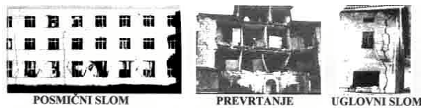
Slika 1. Karakteristična oštećenja kamenom zidanim zgradama u potresu
