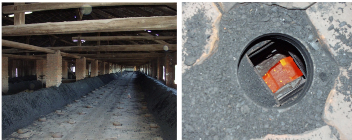
Slika 3.22 Prikaz kova Hofmanove peći: a) krov peći; b) otvori za loženje
