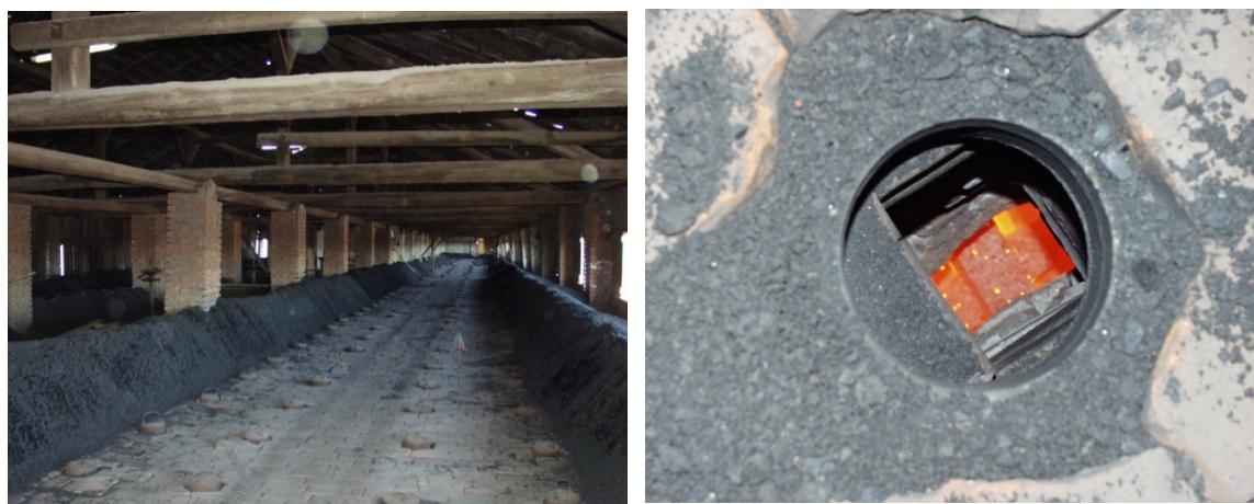
**Slika 3.22** Prikaz kova Hofmanove peći: a) krov peći; b) otvor za loženje
