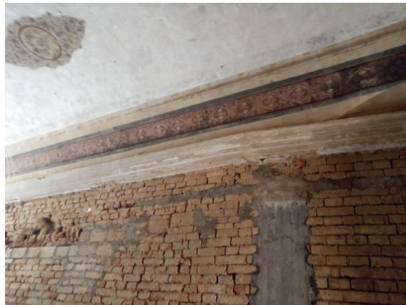
**Slika 4.2** Primjer nekompatibilnog spoja morta i opeke u konstrukciji
