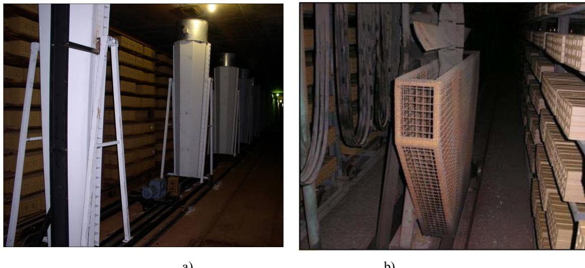
Slika 3.18 Tunelska sušara: a) unutrašnjost; b) ventilator u sušari
