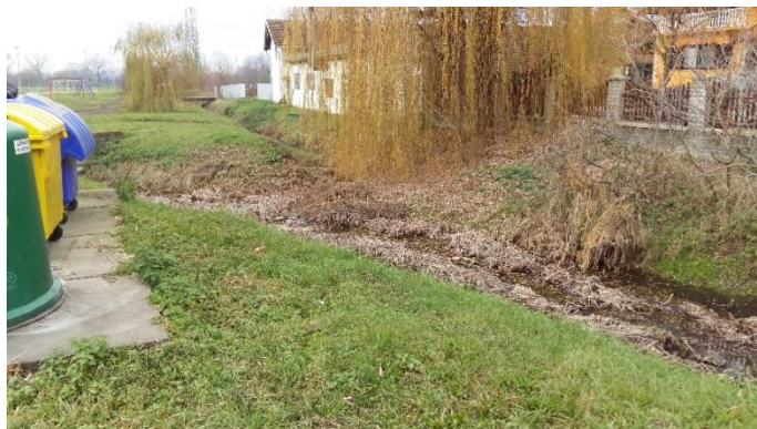
Slika 5.21. Spoj kanala Punovci-Gorjani i kanala Mač
