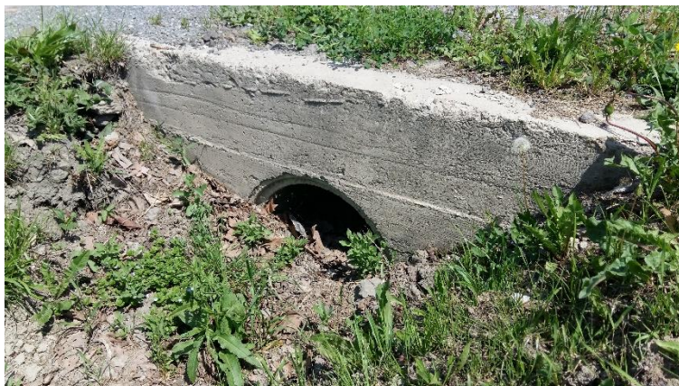
Slika 5.5. ŽC 4085 Željeznička ulica (04.05.2017)
