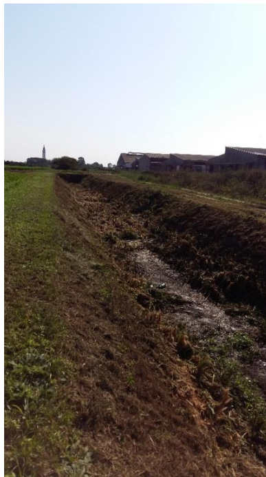
Slika 5.16. Kanal Drobnjak, stac. 1+900
