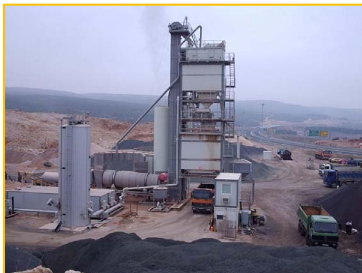
Slika 5-4: Asfaltna baza Posedarje u Posedarju (COLAS Hrvatska d.d.)
