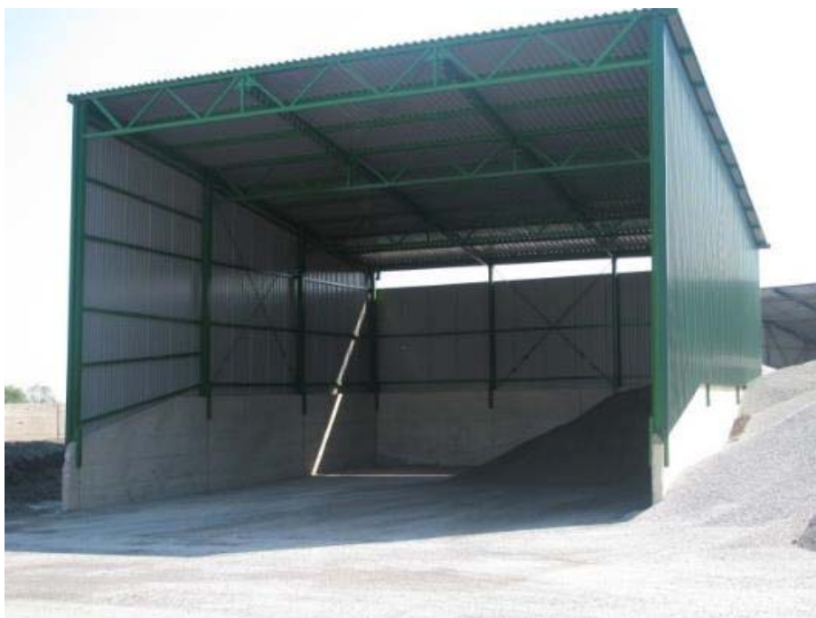
Slika 6-2: Deponija reciklažnog asfaltnog agregata (asfaltna baza Lepoglava, COLAS Hrvatska d.d.)
