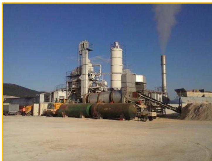
Slika 5-5: Asfaltna baza Ploče u mjestu Kula Norinska (COLAS Hrvatska d.d.)
