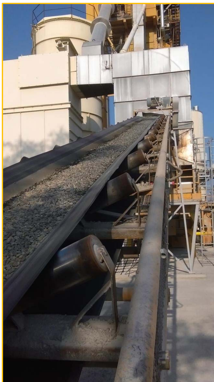
Slika 7-20: Kosa transportna traka na asfaltnoj bazi
