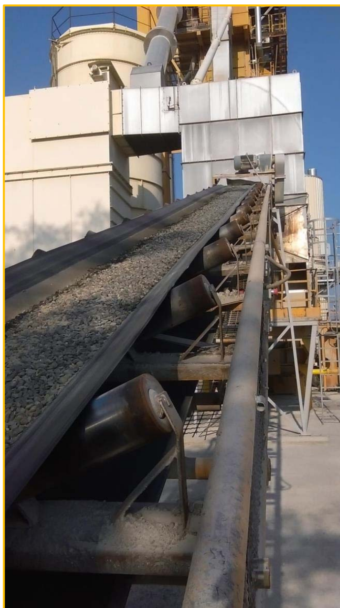
Slika 7-20: Kosa transportna traka na asfaltnoj bazi
