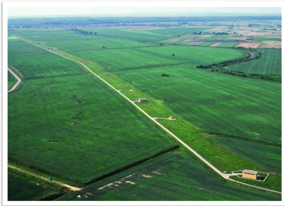
Slika 4.12. Fotografski snimak Crpilišta Vinogradi (Fond dokumenata Vodovoda Osijek, 2000.)
