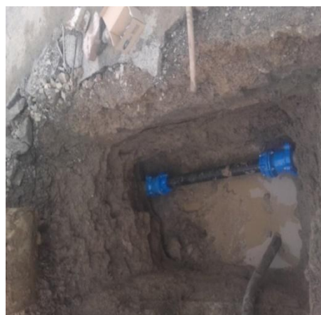
Slika 5. Vidljivo curenje - puknuće azbestno cementne cijevi 15.11.2017., godine u Ulici Zinke Kunc Belišće, puknuta i sanirana azbestno cementna cijev
