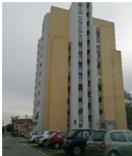
Slika 3: Obnova ovojnica, stolarije i krovšta uz korištenje poticajnih sredstava energetske obnove; zgrada u naselju Sjenjak
