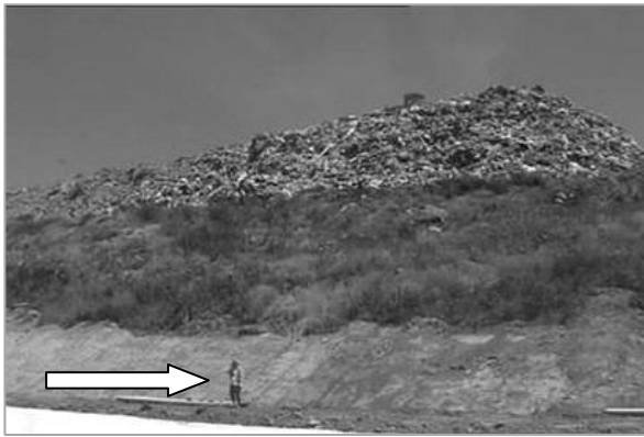
Slika 9 Orlovnjak - regionalno odlagalište otpada [28]
