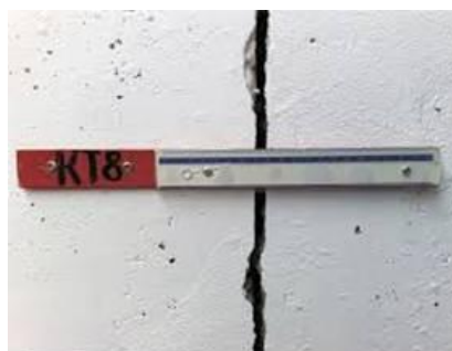
Slika 9. Ravnalo za mjerenje vertikalnih pukotina
