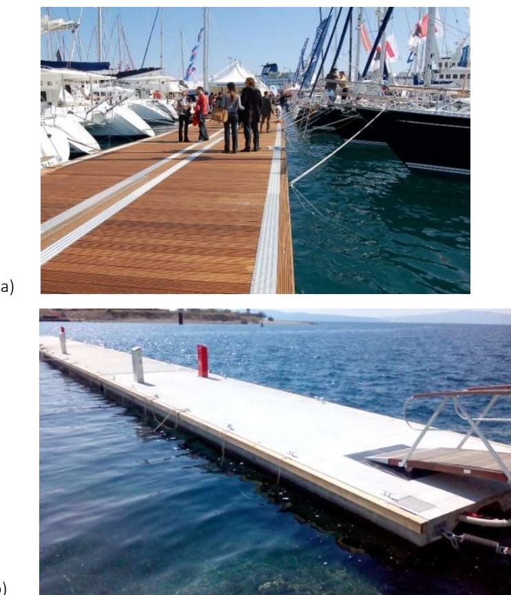
Slika 10. Primjer hodne površine na pontonu: a) drvena hodna površina, b) beton
