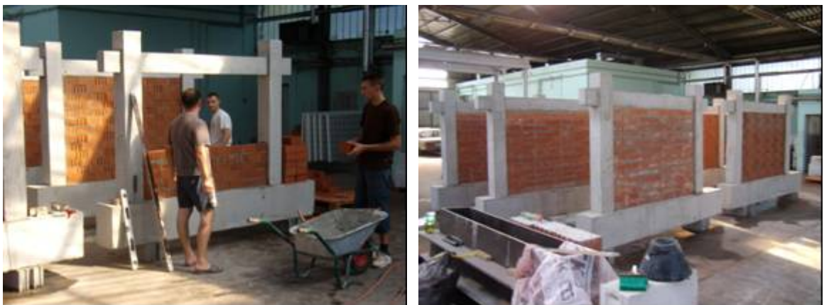
Slika 4.5 Prikaz zidanja zidnog ispuna od opečnih blokova MO5
