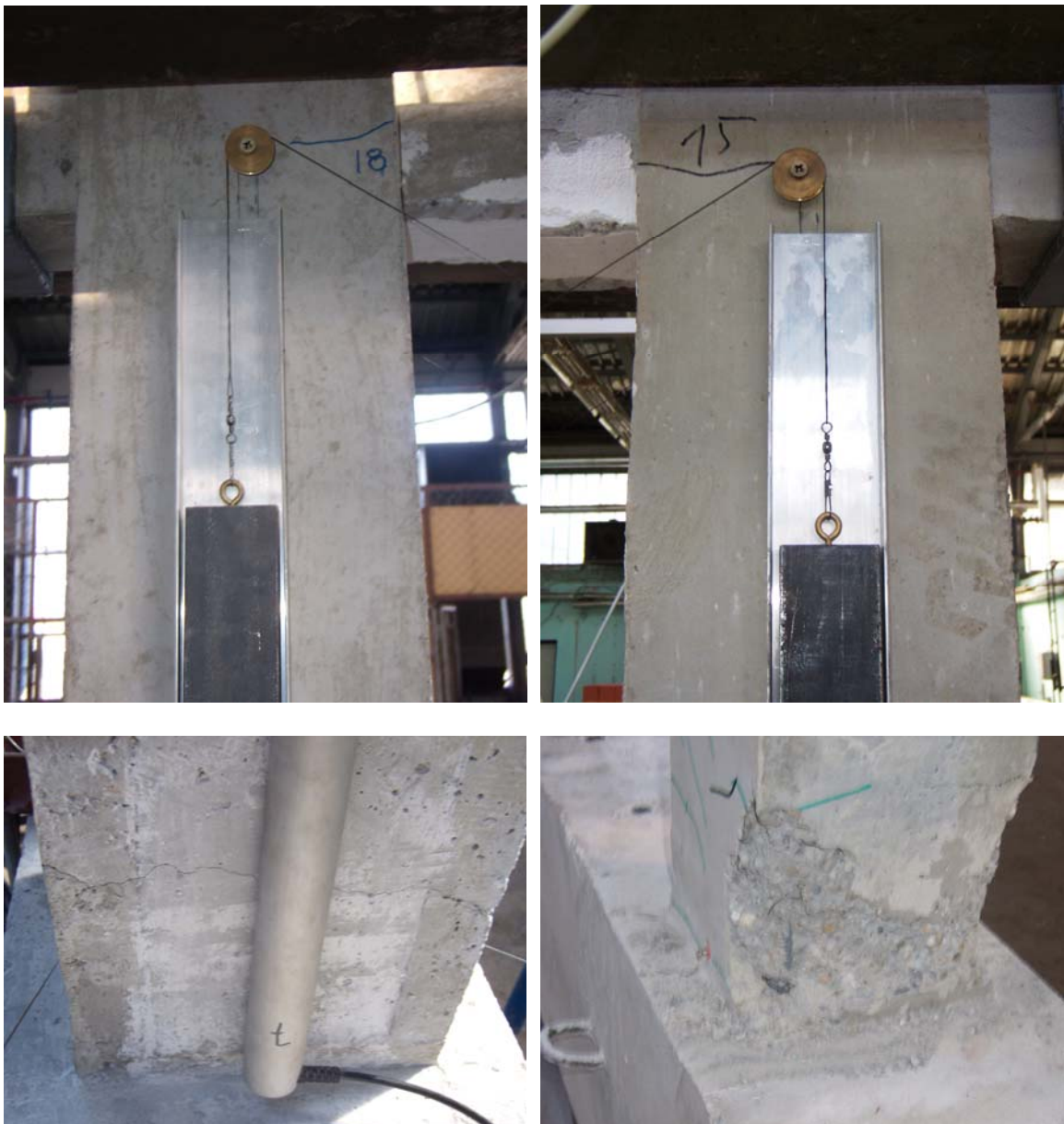
Slika 4.42 Prikaz pukotina na MODELU 10
