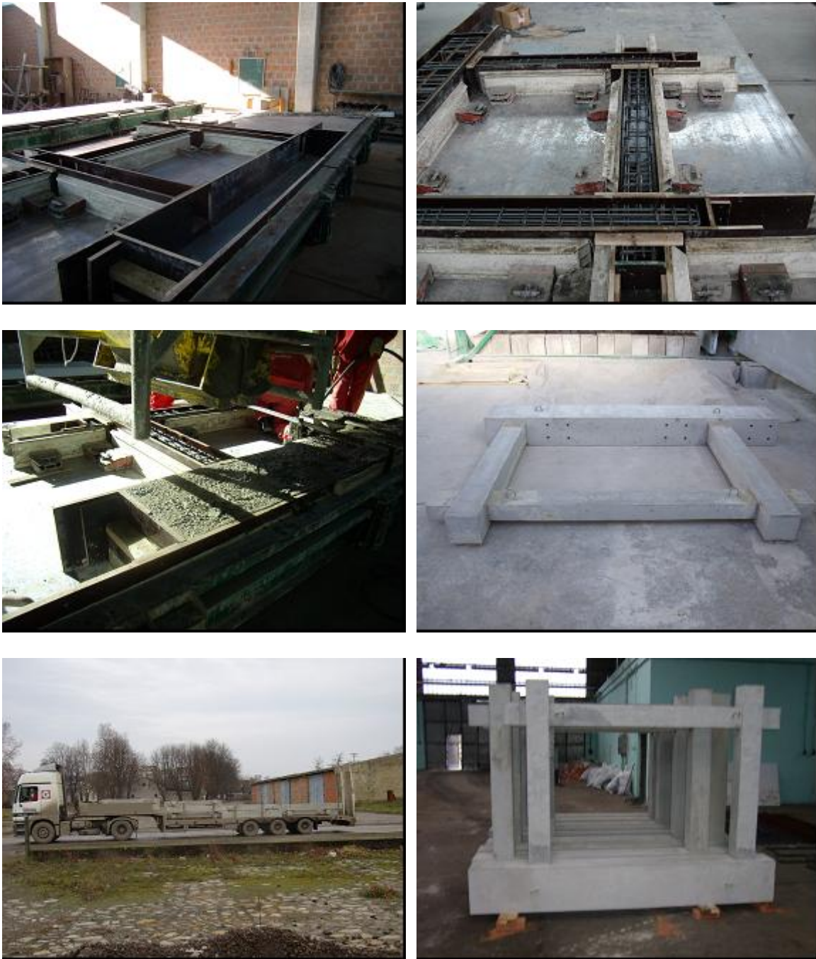
Slika 4.3 Prikaz izrade i dopreme armirano-betonskih okvira modela
