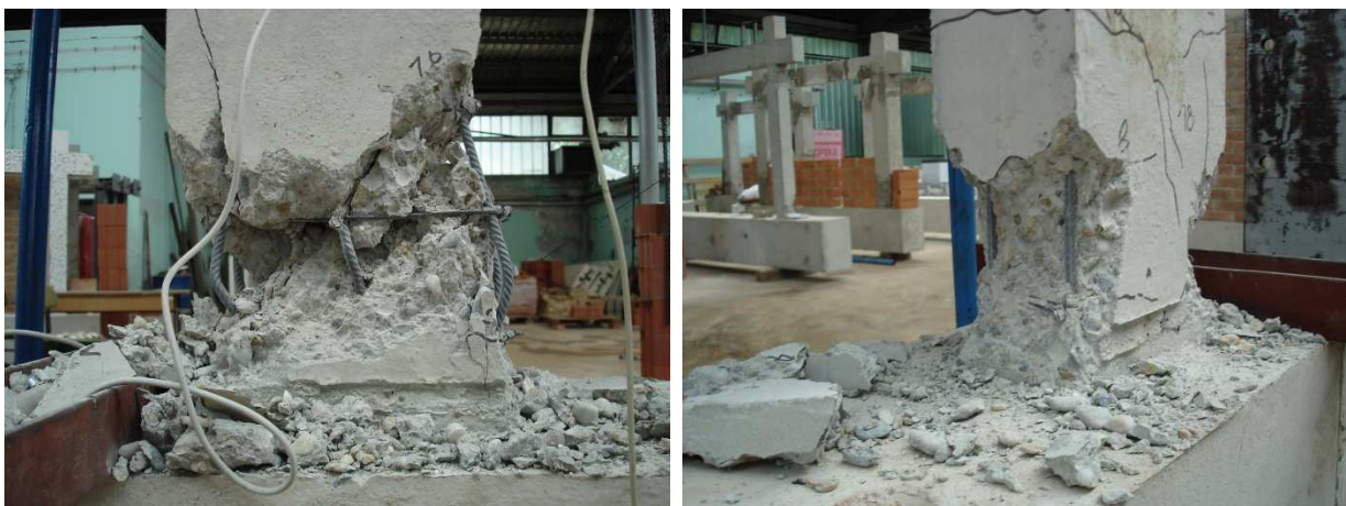
Slika 6.88 Slom i oštećenje stupova ispitnog uzorka O3
