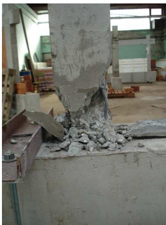
c) Oštećenje lijevog stupa ispitnog uzorka
