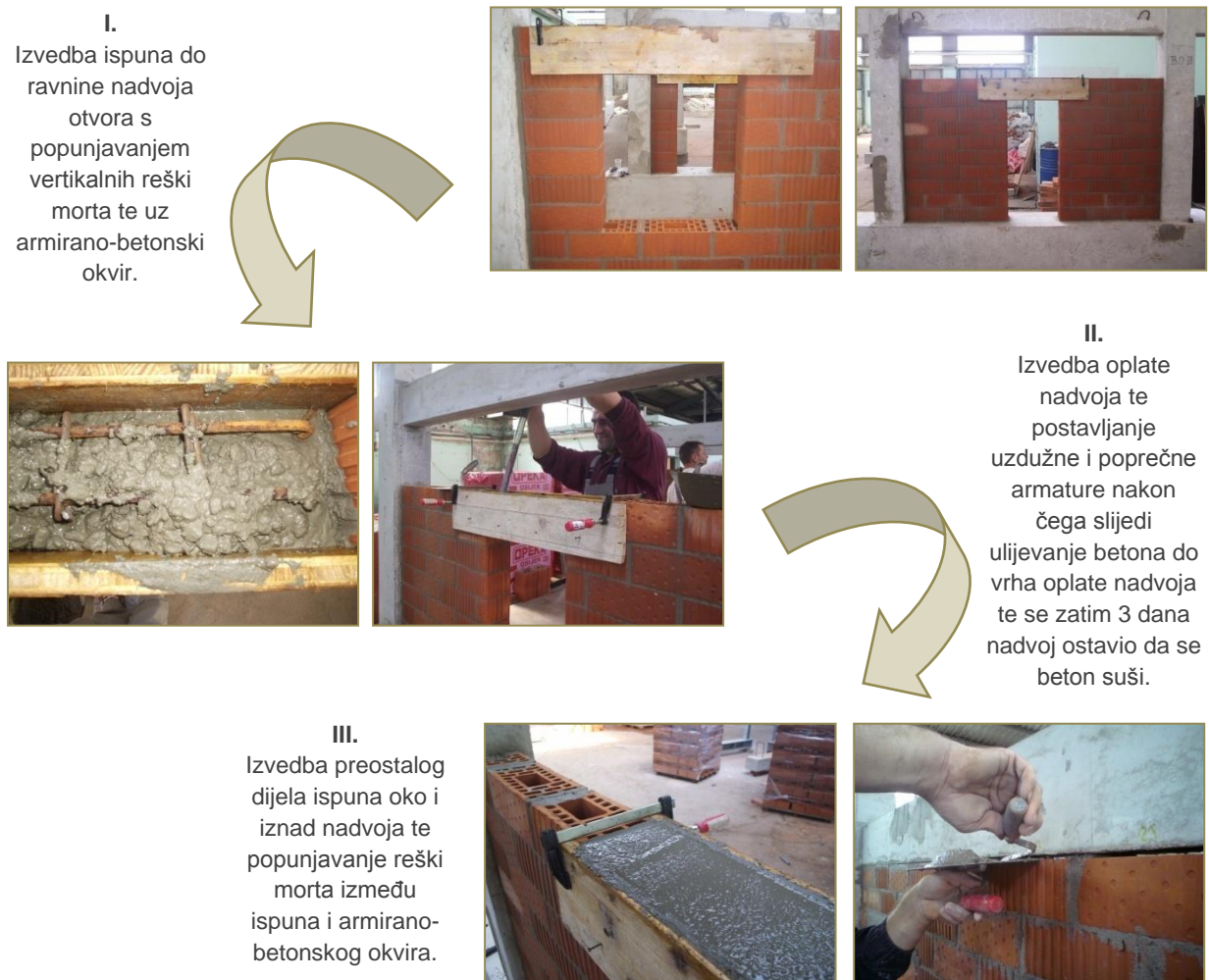
Slika 2.23. Redosljed postupaka pri pripremi uzoraka grupe I
