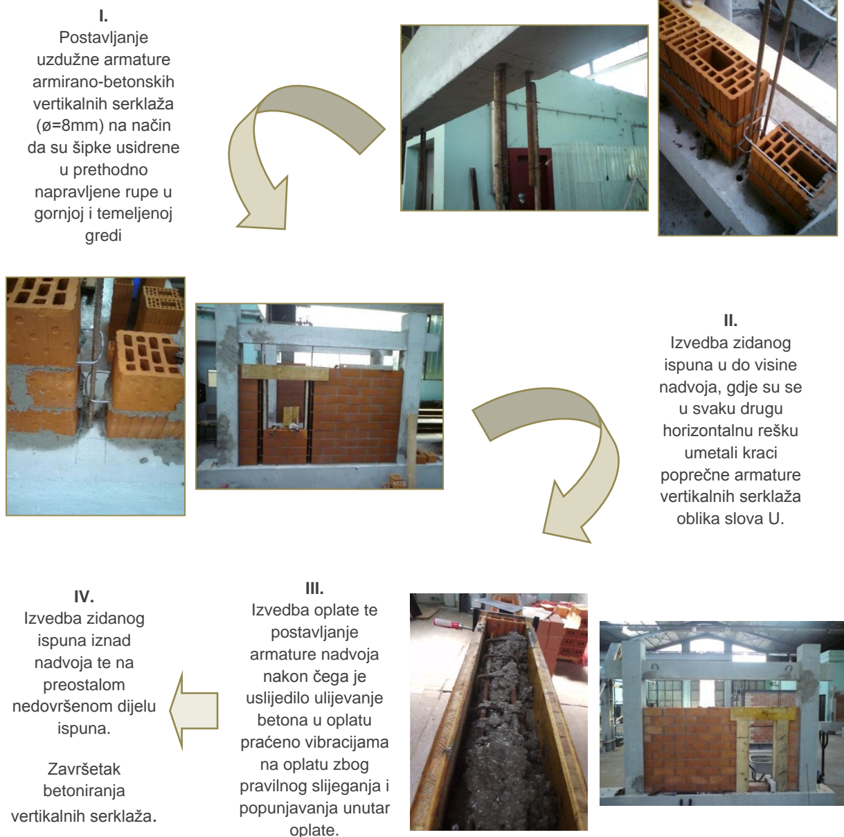
Slika 2.24. Redoslijed postupaka pri pripremi uzoraka grupe II
