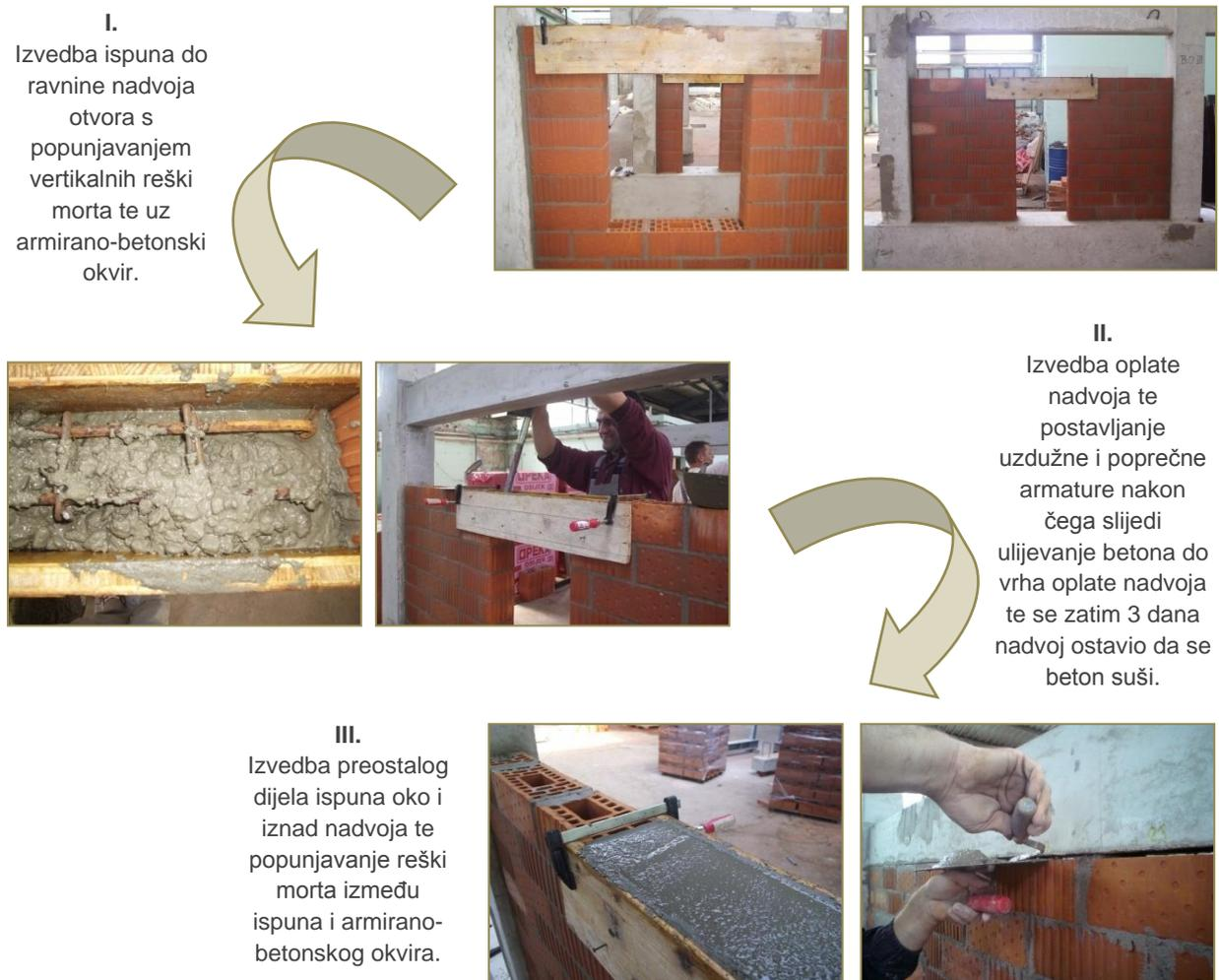
Izvedba zidanih ispuna uslijedila je nakon popravka armirano-betonskih okvira, nakon što je utvrđeno da je nanošeni mort za popravak okvira očvrsnuo. Redoslijed postupaka izvedbe za uzorke grupe I opisan je u tablici 2.31., a grupe II u tablici 2.32. Pristup izvedbi zidanog ispuna uzoraka grupe I i II su zbog izvedbe vertikalnih serklaža različiti. Poprečna armatura vertikalnih serklaža, tijekom izvedbe zidanog ispuna polagana je u horizontalne reške morta.
