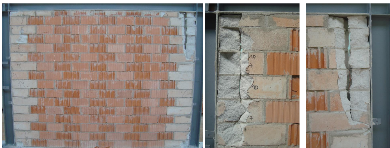
Slika 4.76 – Oštećenja okvira sa zidanim ispunom – OGY-1
