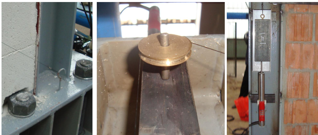
Slika 4.33 - Mjerenje produljenja/skraćenja dijagonala čeličnog okvira
