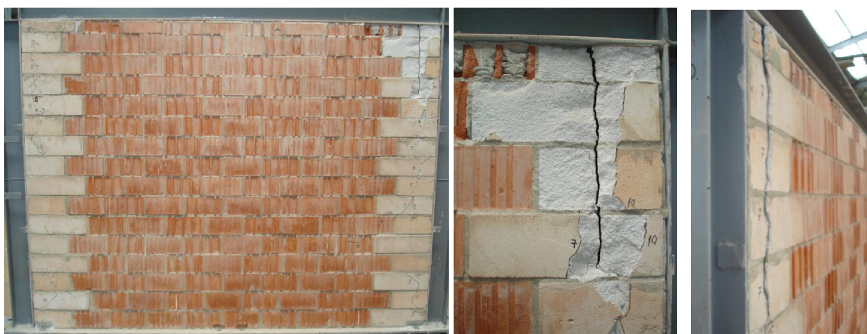
Slika 4.77 – Oštećenja okvira sa zidanim ispunom – OGY-2
