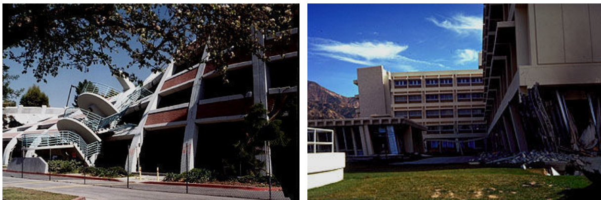
Slika 1. Oštećenja građevina uslijed djelovanja potresa
