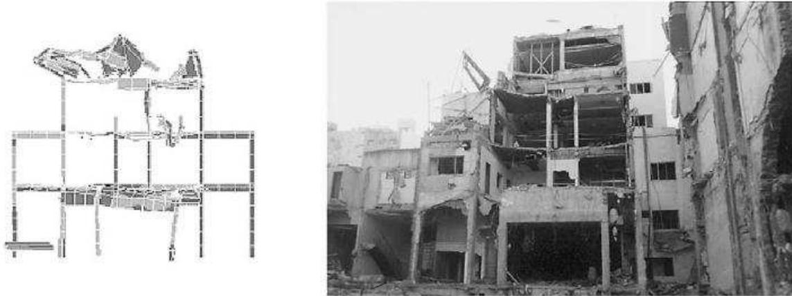
**Slika 2.4 – Krajnje stanje simulacije i konstrukcije nakon eksplozije [9]**
