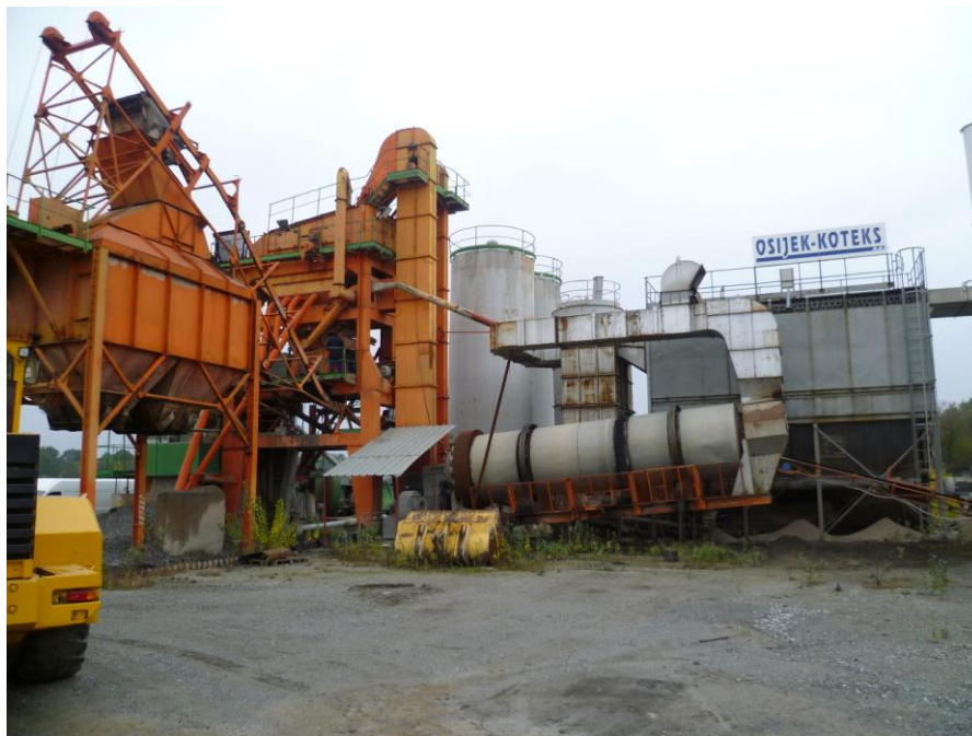
Slika 31. Asfaltno postrojenje u Lužanima
