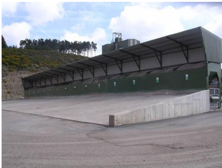
Slika 17. Natkriveni spremnici mineralne mješavine [120]
