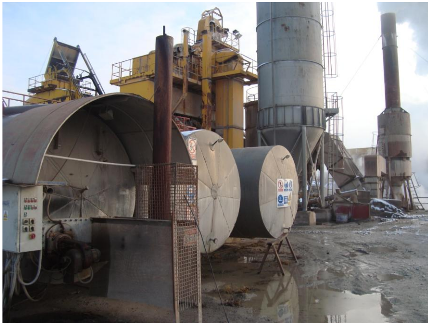
Slika 30. Asfaltno postrojenje u Nemetinu
