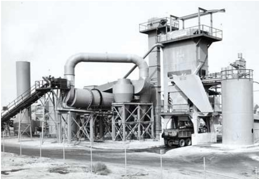
Slika 6. Asfaltno postrojenje iz 60-ih godina 20. stoljeća [44]
