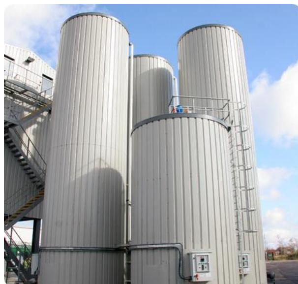
Slika 28. Vertikalni spremnici za bitumen [130]
