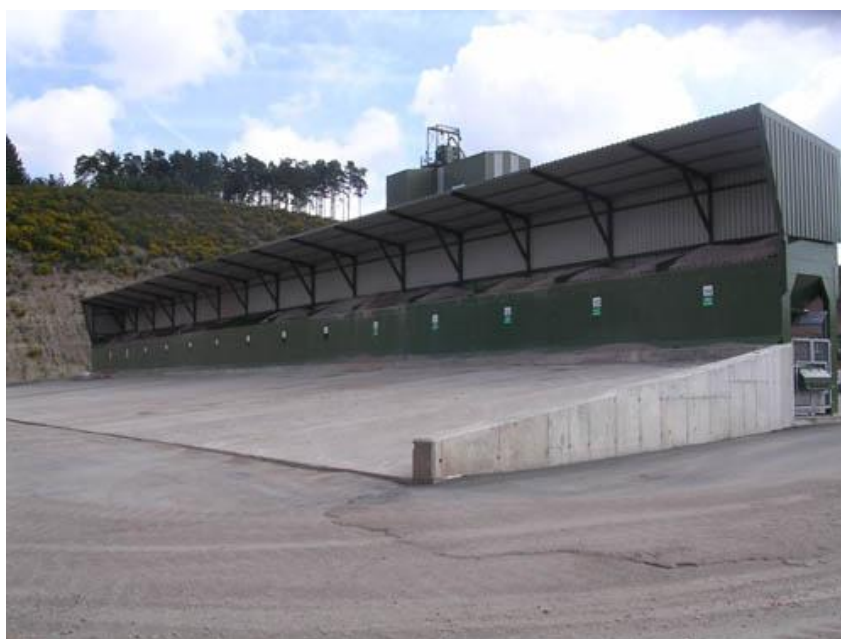
Slika 17. Natkriveni spremnici mineralne mješavine [120]
