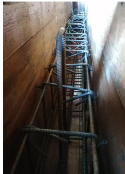
Slika 7.3 Prikaz armature za AB grede
