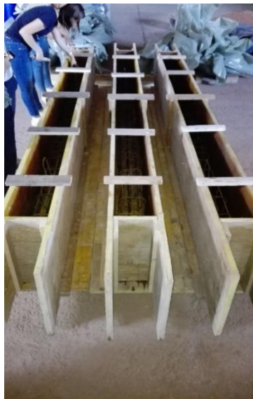
Slika 7.2 Prikaz oplate za AB grede
