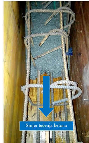
Slika 7.4 Tečenje betona pod djelovanjem vlastite težine
