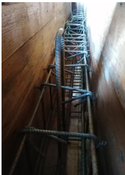
Slika 7.3 Prikaz armature za AB grede
