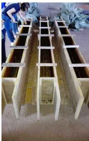
Slika 7.2 Prikaz oplate za AB grede
