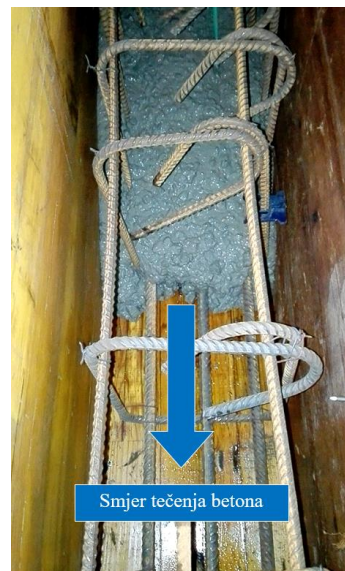
Slika 7.4 Tečenje betona pod djelovanjem vlastite težine
