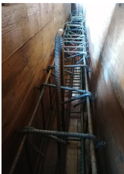
Slika 7.3 Prikaz armature za AB grede
