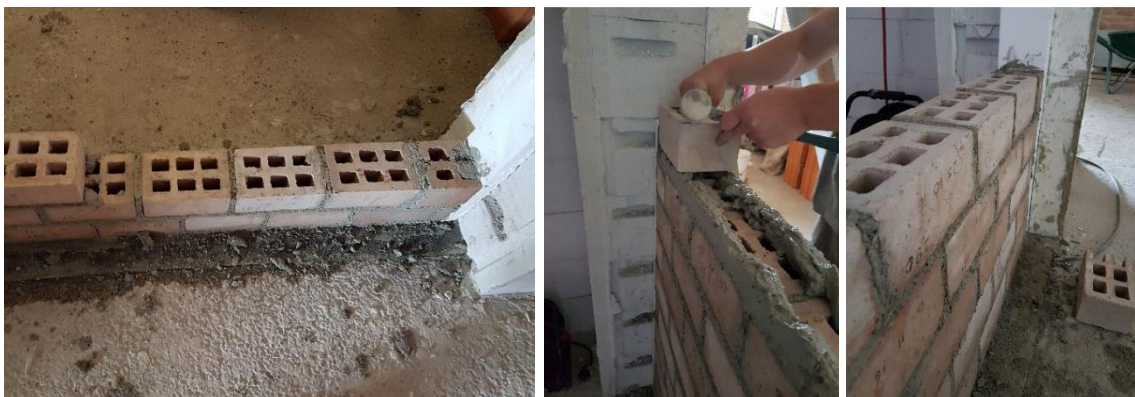
Slika 4.13 Zidanje zida od betonskih zidnih elemenata s recikliranom opekom
