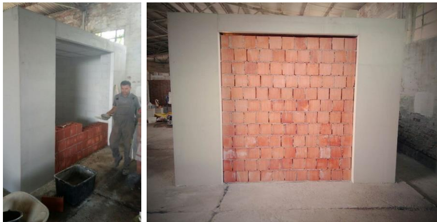
Slika 4.6 Zidanje zida od šuplje blok opeke
