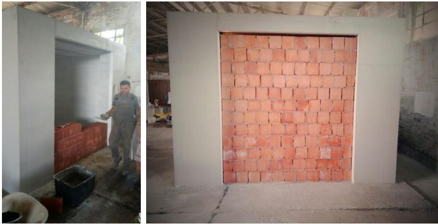
Slika 4.6 Zidanje zida od šuplje blok opeke
