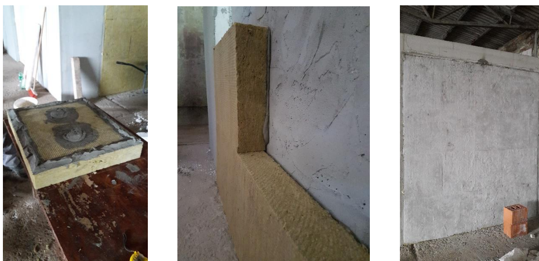
Slika 4.5 Postavljanje toplinske izolacije od kamene vune
