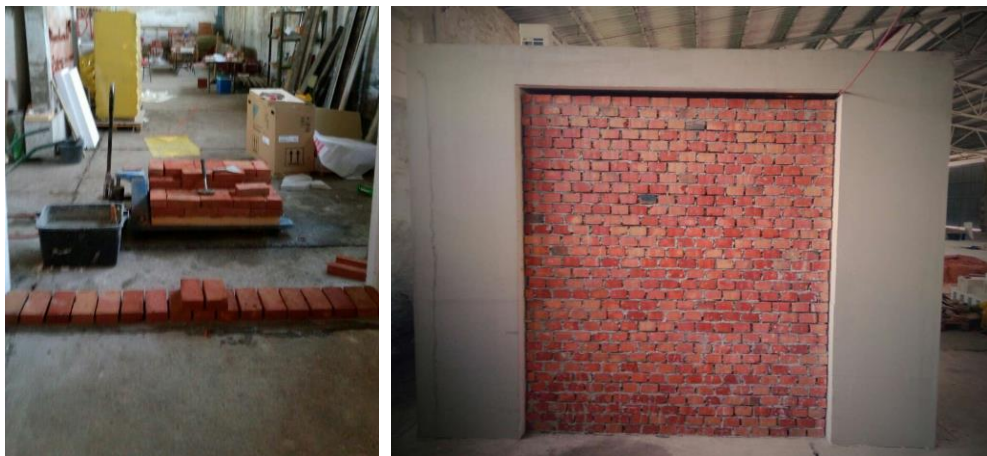
Slika 4.7 Zidanje zida od pune opeke
