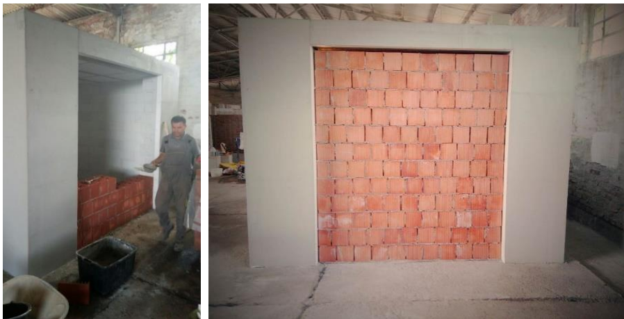
Slika 4.6 Zidanje zida od šuplje blok opeke
