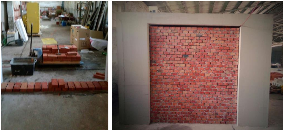
Slika 4.7 Zidanje zida od pune opeke
