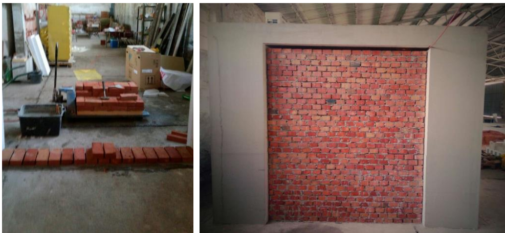
Slika 4.7 Zidanje zida od pune opeke
