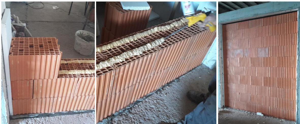
Slika 4.8 Zidanje zida od brušene šuplje blok opeke
