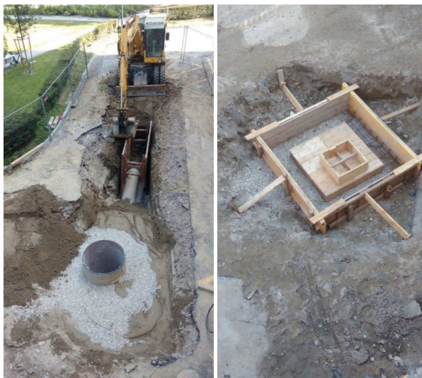
Slika 3.7. Prikaz postavljanja nove kanalizacijske cijevi i izrade kontrolnog okna
