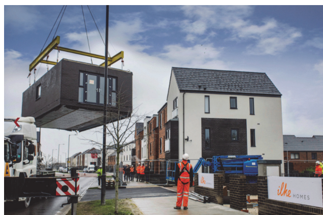
Slika 13. Postavljanje čeličnog modula kuće [24]
