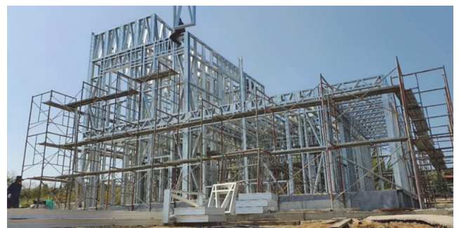
Slika 9. Izvedba urbane vile laganim panelnim sustavom gradnje [19]
