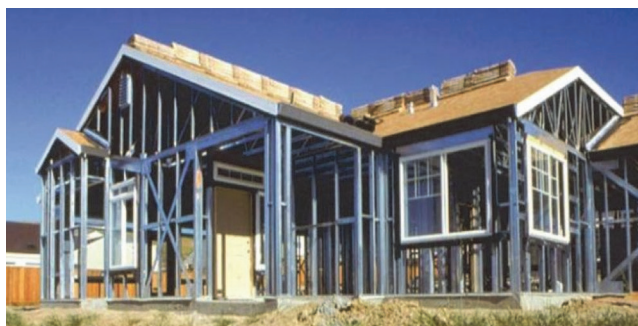
Slika 1. Kuća s čeličnom konstrukcijom [2]
