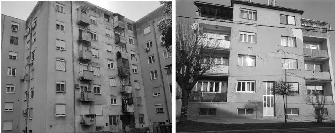
a) zgrada u Osijeku
