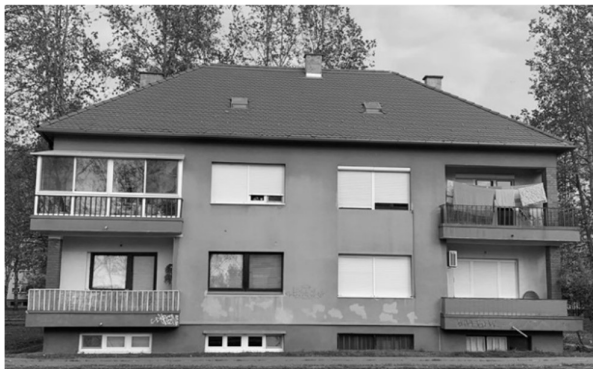
a) zgrada u Osijeku
