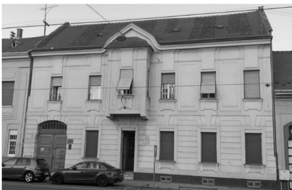
a) zgrada u Osijeku
