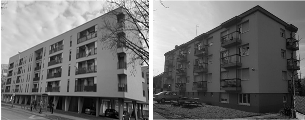
a) zgrada u Osijeku
