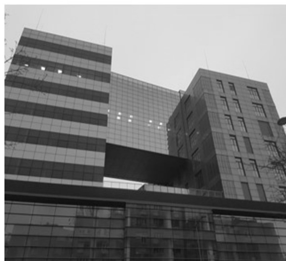
d) novija armirnobetonska zgrada (armirnobetonski okvir)
