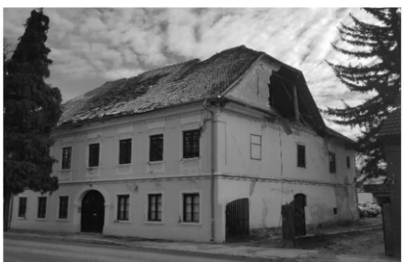
b) zgrada u Petrinji snimljena nakon potresa 28.12. 2020.
