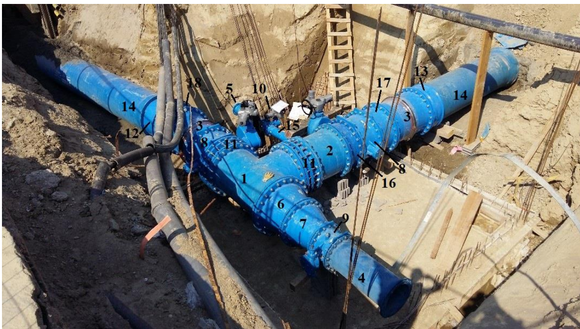
Slika 6.7 Čvorište s postavljenim fazonskim komadima, armaturama i betoniranom donjom pločom i pripremljenom armaturom za zidove okna
