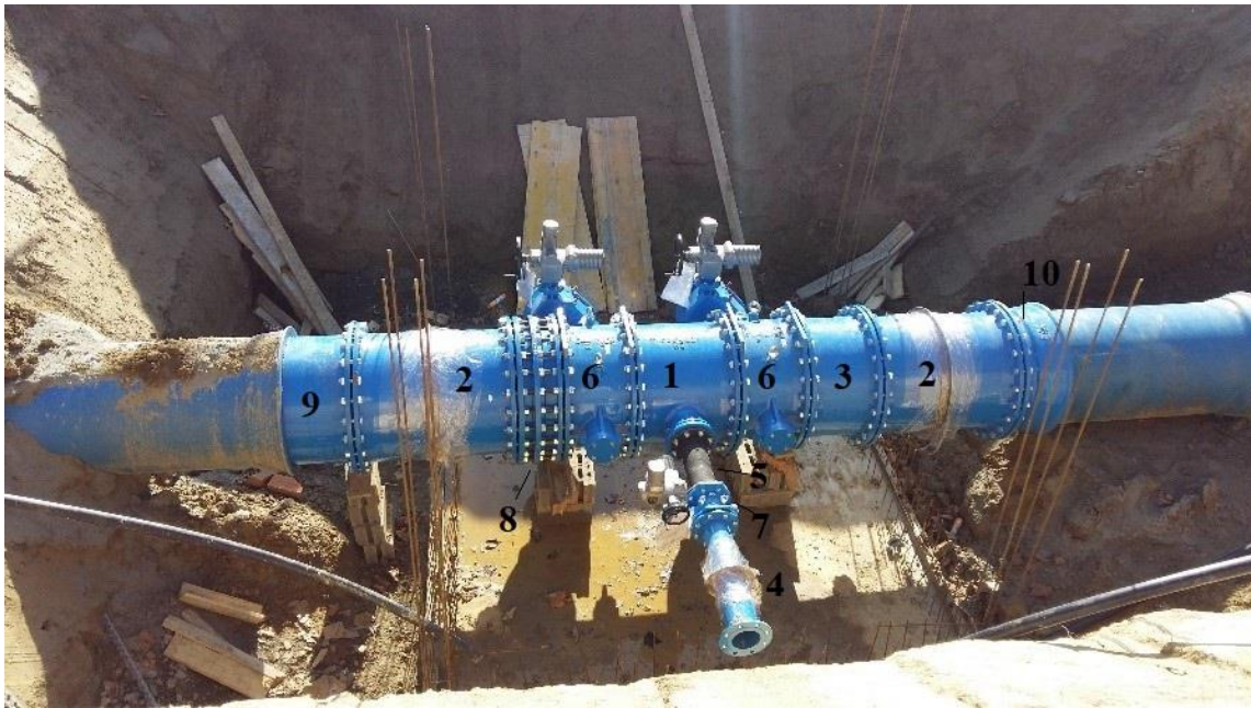
Slika 6.6 Čvorište s postavljenim fazonskim komadima, armaturama i izbetoniranom donjom pločom i pripremljenom armaturom za zidove okna
