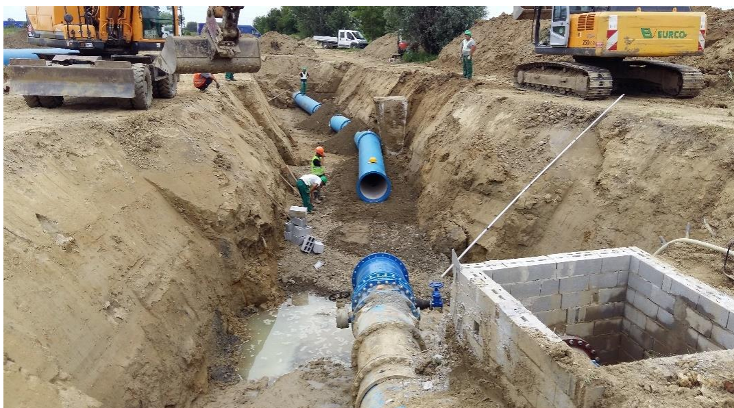
Slika 6.10 Čvorište s postavljenim fazonskim komadima, armaturama i pripremljenom oplatom; vidljiva podzemna voda unutar građevne jame uslijed gašenja crpke za snižavanje podzemnih voda [10]
