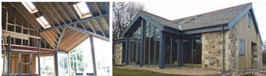
Slika 7. Obiteljska kuća izgrađena u kombinaciji čelika i drva [16]
