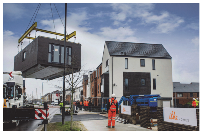
Slika 13. Postavljanje čeličnog modula kuće [24]
