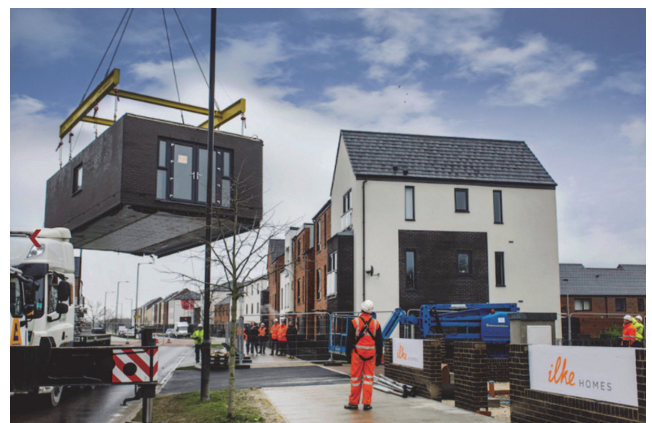
Slika 13. Postavljanje čeličnog modula kuće [24]
