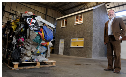
Slika 14. Montažna kuća od reciklirane plastike u Velikoj Britaniji [22]
