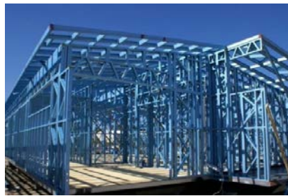
Slika 13. Montažni sustav od metala [21]
