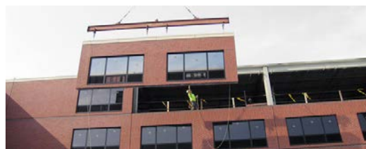
Slika 11. Montažni sustav od opekarskih proizvoda [18]
