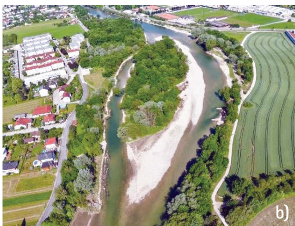
Slika 3: Rukavac Yabbsknie Amstetten prije a) i poslije izvođenja radova b), ( http://www.life-mostviertel-wachau.at )
