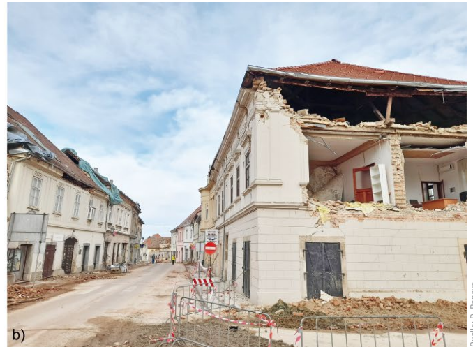
Bild 8 Typisches Schadensbild in Petrinja (Kroatien): a), b) Teileinsturz oberer Geschosse und Giebelwände (Schadensgrad 4) Typical damages Petrinja (Croatia): Partial collapse of upper floors and gable walls (damage grade 4)
