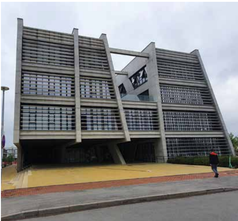
Moderna zgrada Fakulteta građevinarstva i arhitekture završena je 2016. godina
