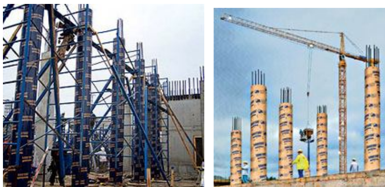
Slika 4 – Primjer korištenja recikliranog kartona u obliku oplata [11]
