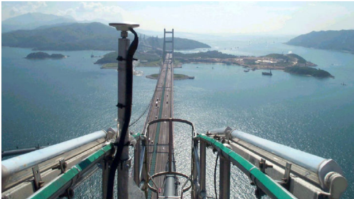
Slika 6 – GPS antena na vrhu pilona
