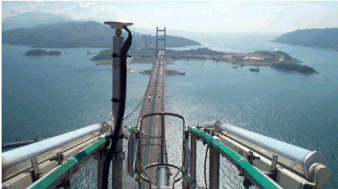
**Slika 6 – GPS antena na vrhu pilona**
