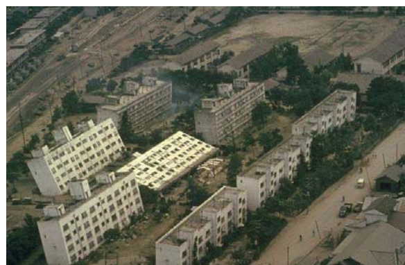
Slika 1 - Posljedice pojave likvefakcije nakon potresa iz 1964. godine: Aljaska (lijevo) [4] i Niigata (desno) [5]
