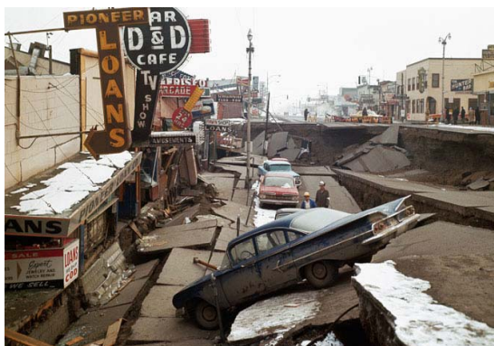
Slika 1 - Posljedice pojave likvefakcije nakon potresa iz 1964. godine: Aljaska (lijevo) [4] i Niigata (desno) [5]
