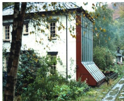
Slika 12b - Obiteljska kuća- zapadni Wales, Velika Britanija
