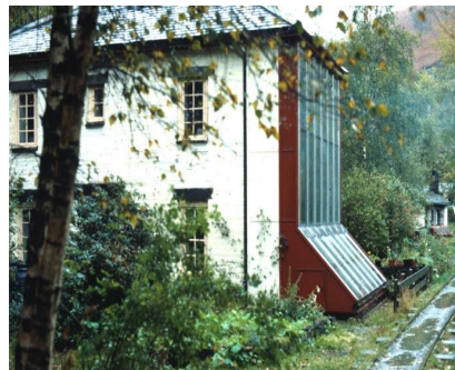
Slika 12b - Obiteljska kuća- zapadni Wales, Velika Britanija
