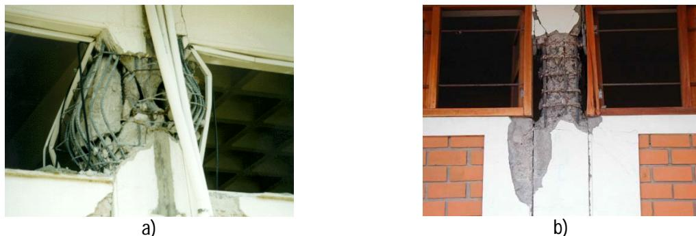
**Slika 1 – Primjeri oštećenja kratkih stupova: a) detalj peterokatnice izgrađene 1997. godine prema Grčkim propisima za proračun konstrukcija otpornih na potres [1]; b) spone O10 na razmaku od 10 cm nisu spriječile teška oštećenja na stupu nastala djelovanjem potresa [2]**
