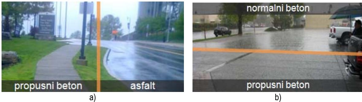
**Slika 5 – usporedba vodopropusnosti prometnih površina izrađenih od propusnog betona i drugih materijala: a) pješačka staza i kolnik, [15]; b) parkiralište, [16]**
