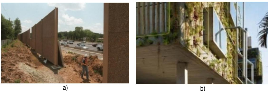
**Slika 7 - Vertikalni elementi od propusnog betona: a) bukobran, [20]; b) pročelje uredske zgrade, [21]**
