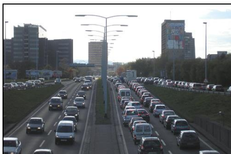
Slika 3 - Pogled s nadvožnjaka ulice HBZ [8]
