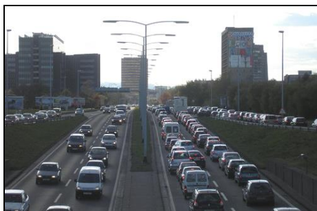
Slika 3 - Pogled s nadvožnjaka ulice HBZ [8]
