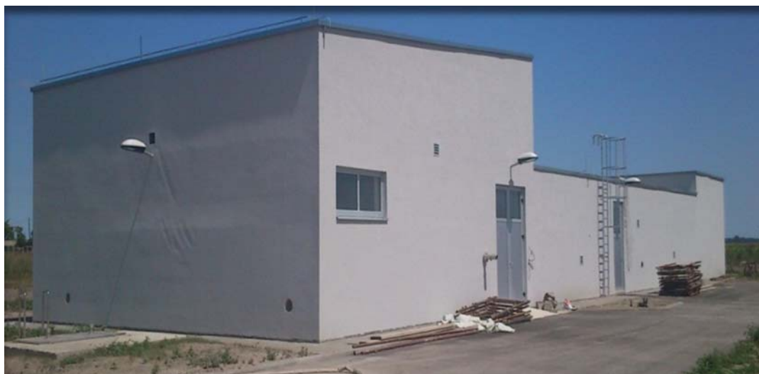
Slika 5 - Pogled na izgrađenu zgradu UPOV-a Kneževi Vinogradi
