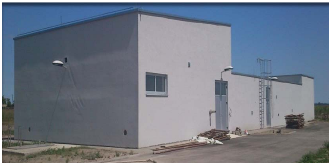
Slika 5 - Pogled na izgrađenu zgradu UPOV-a Kneževi Vinogradi
